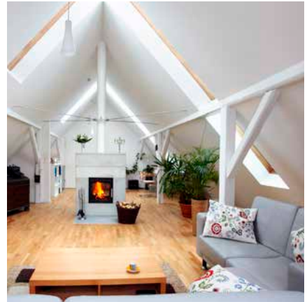
Tapezierter/gestrichener Gipskarton unter den Sparren
